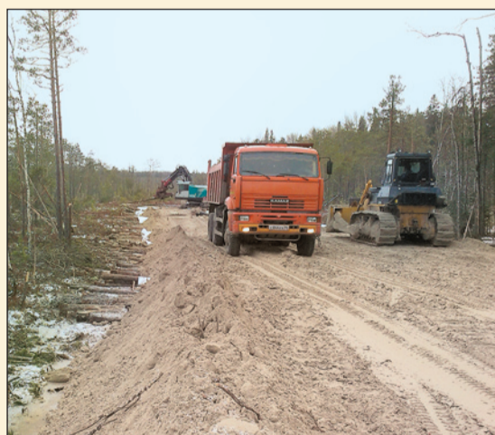
Строится автодорога на Верхнюю Шапшу
