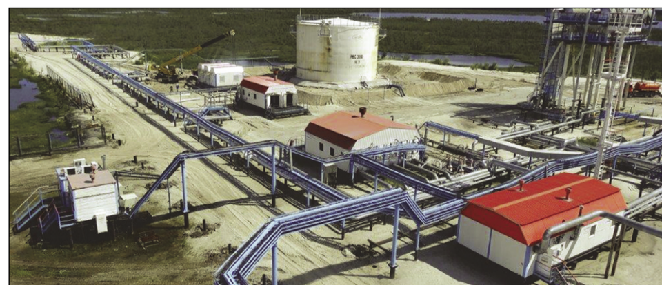
Компания продолжает развиваться. На Рославльском месторождении в Сибири завершается строительство блочной кустовой насосной станции.
