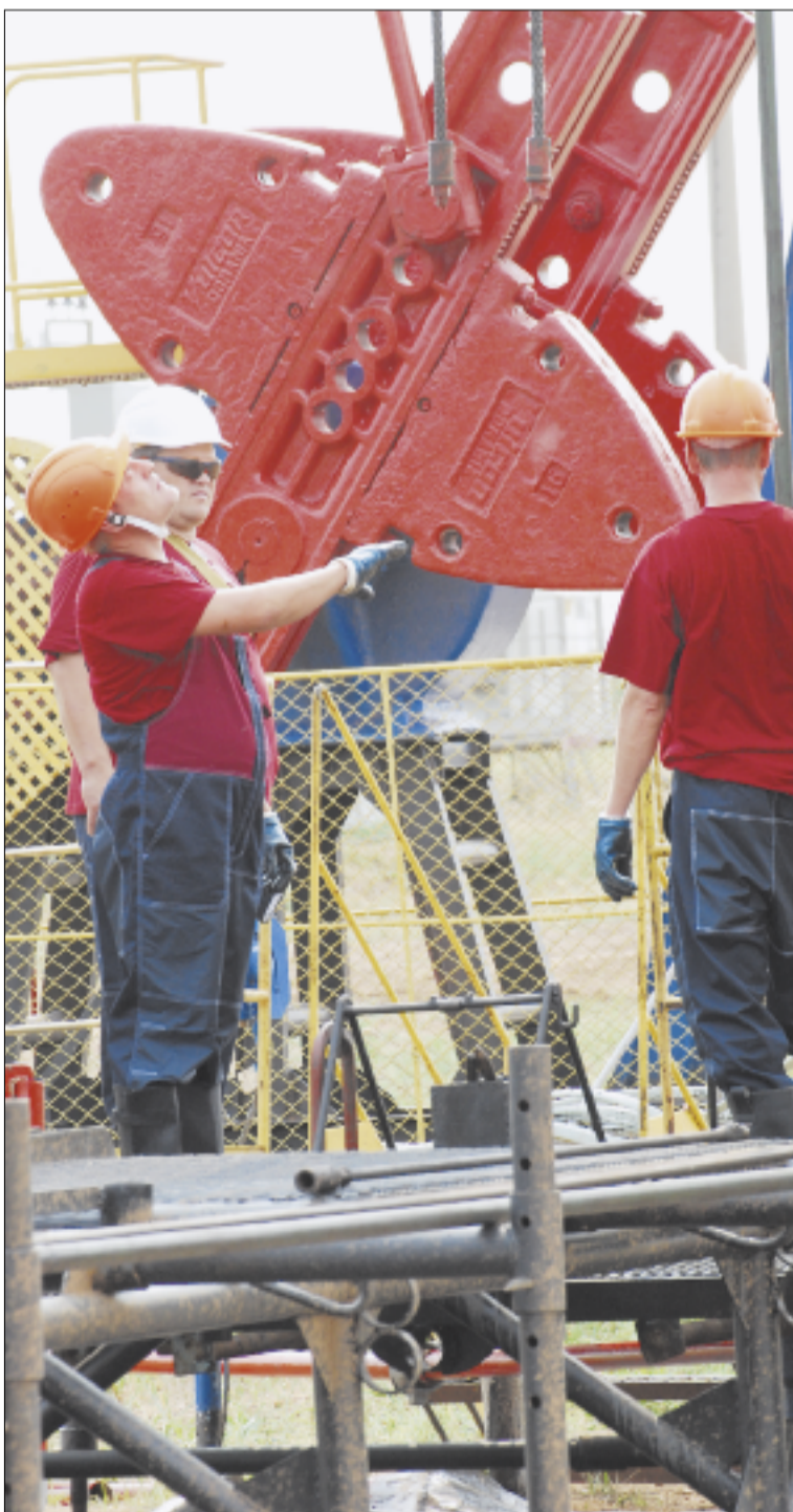
■ Соревнуются бригады капитального ремонта скважин.
