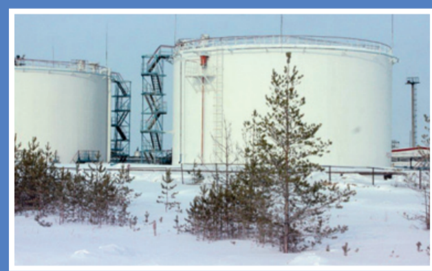
«Варьеганефть» продолжала активно разбуривать Тагринское месторождение. Год нефтяники из Радужного начали с «низкого старта»: на участке недр в январе пробурили три горизонтальные скважины.
